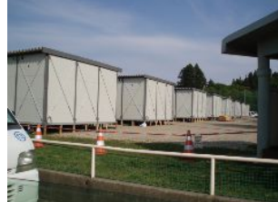
↑教会近くの反松公園では、仮設住宅の建設が進んでいました。少し前は、ここはガレキが山のように積まれていました。丸太を縦にし、その上に、住宅は乗っていました。
